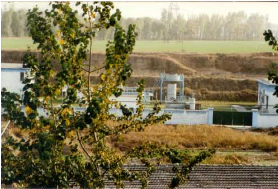
图 6 南顺油脂厂污水处理工程全景
